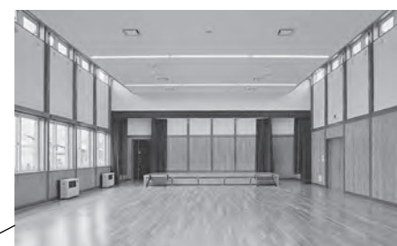
壁面のデザインに町産カラマツ材直交集成板（CLT）を使用
