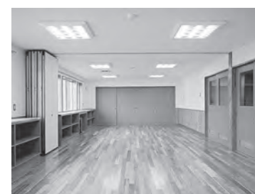
可動間仕切りを設置、2室1間
