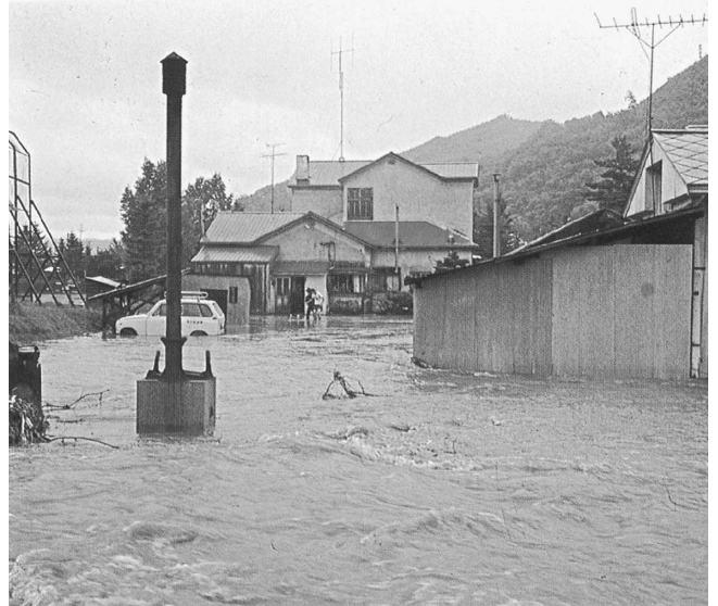
昭和50年の大水害。林友方面で床上浸水被害が発生
