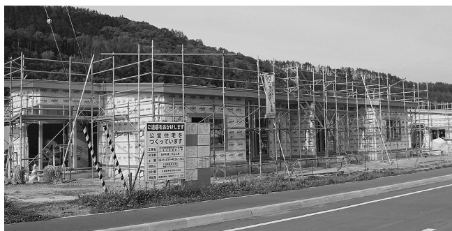
まちなか団地に建設中の町営住宅
