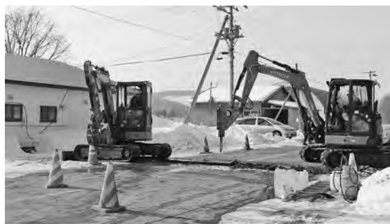
中里地区の各戸給水管敷 設工事（先月）
