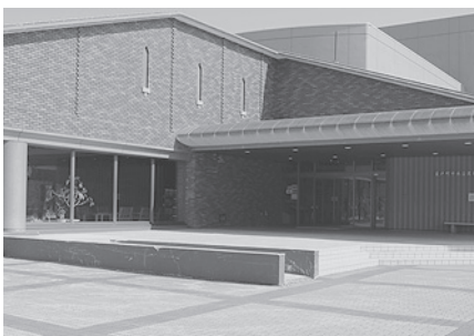
▼中央公民館の階段とスロープ
