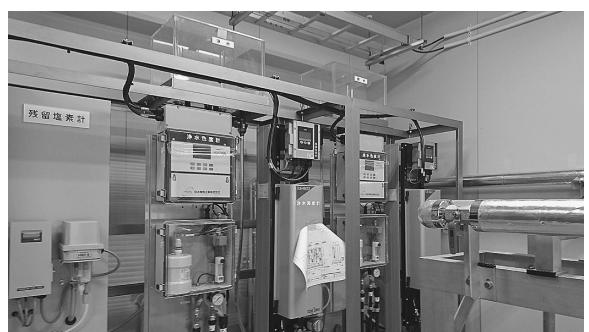
置戸浄水場の水質測定装置
