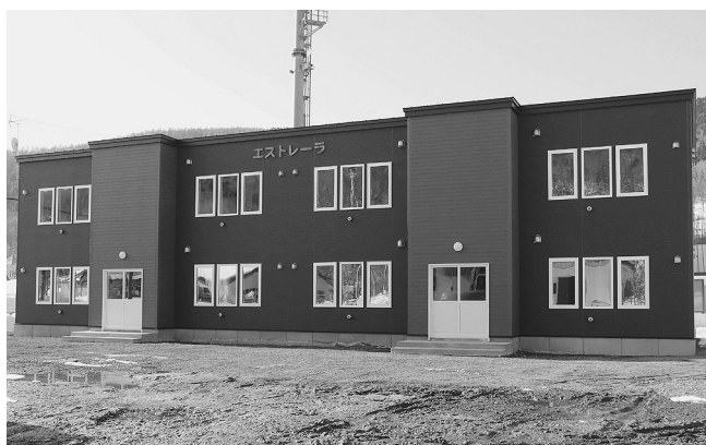
▲民間賃貸住宅の建設に対する支援を行います
