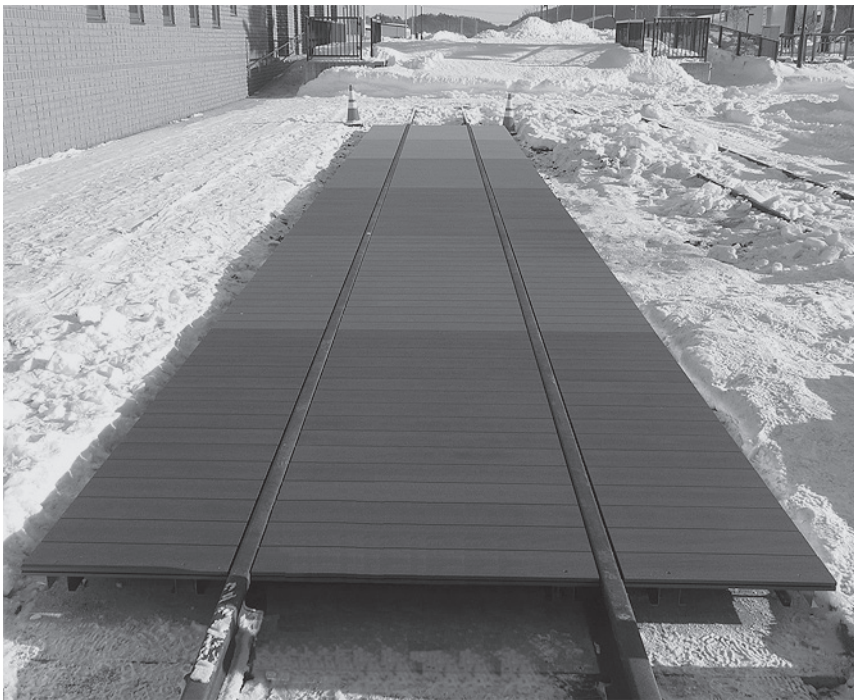
▲試験施工されたぼっぱ裏の木道プロムナード
