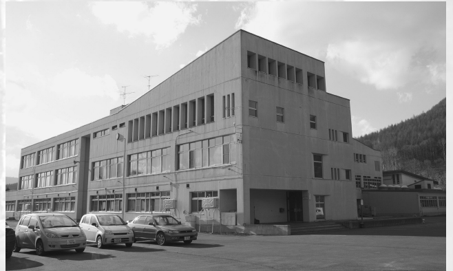
耐震改修が行われる置戸中学校
