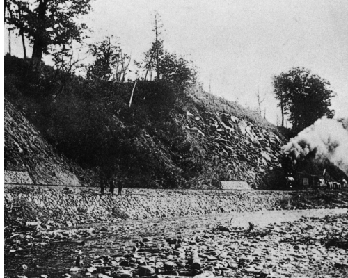
網走本線建設ではここ(学友橋下手)が難所だった
