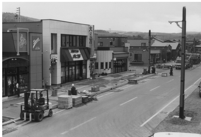
広くなった歩道にはインターブロックを敷設
