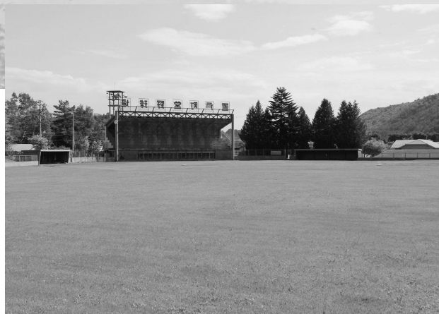
改修工事が行われる町営野球場
