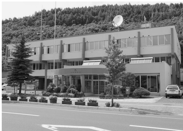
耐震診断が行われる役場庁舎
