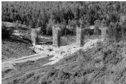
工事中の堤体
