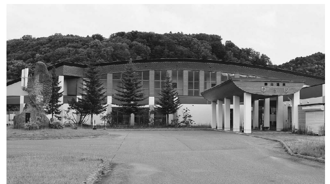
改修工事が行われる「勝山温泉ゆうゆ」
