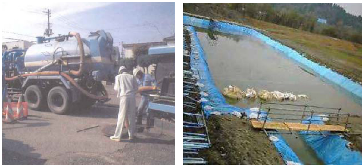
図4-10. 左：緊急措置例（滞留汚水の吸引）、右：応急復旧例（仮設沈殿池）
